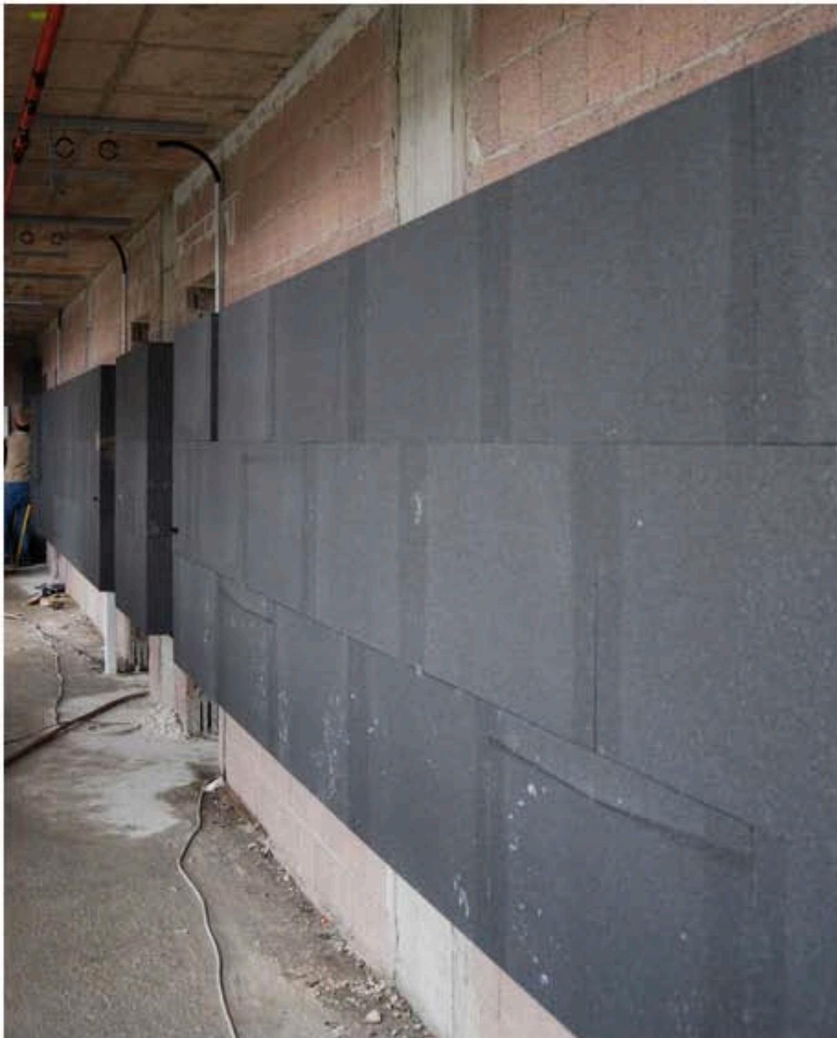
Il pannello Eco-Por G031 in eps realizzato con Neopor di Basf e certificato Epd in Italia.
