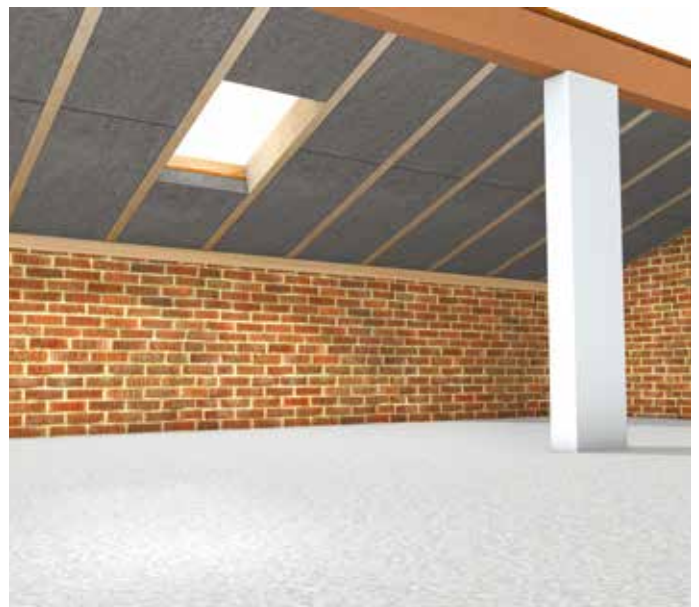
Isolamento del sottotetto con travi a vista
